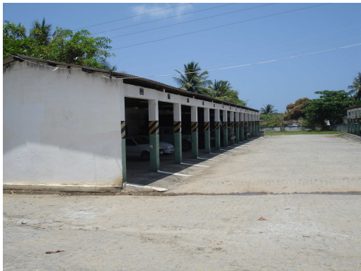
Galpão de estacionamento veículos
